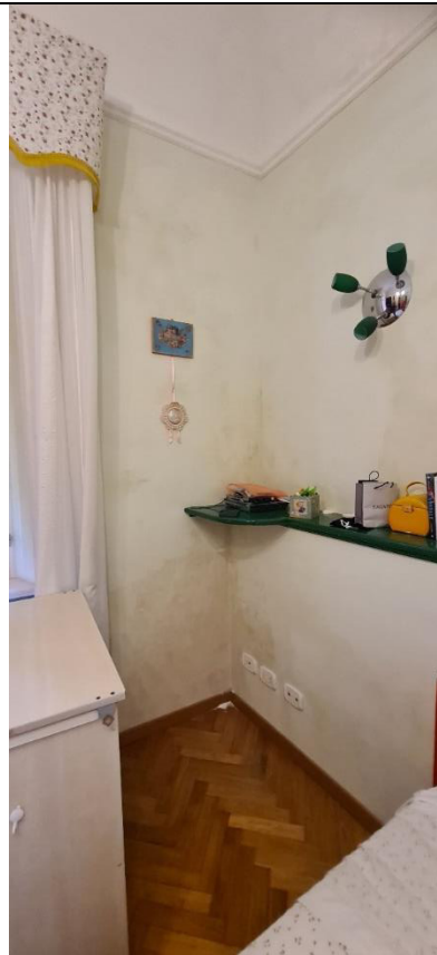
PARETE DEL CONFINANTE CON CONTROPARETE IMPREGNATA (VEDUTA INTERNA)
