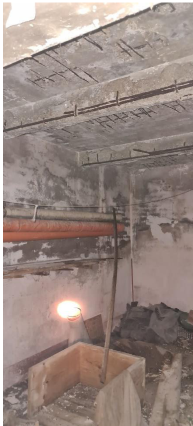
LOCALE PIANO PRIMO SEMINTERRATO
