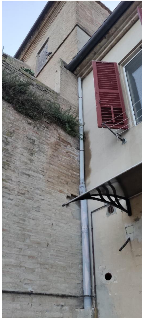
DETTAGLIO DELLA PARETE DI CONFINE AL DI SOTTO DEL TERRAZZO OGGETTO DEI LAVORI (VEDUTA ESTERNA)
