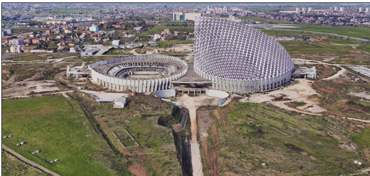
Vista del cantiere Città dello Sport
