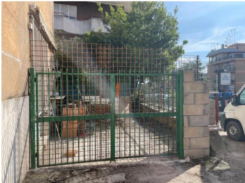
Figura 13 - Chiusura cancello con rete elettrosaldata
