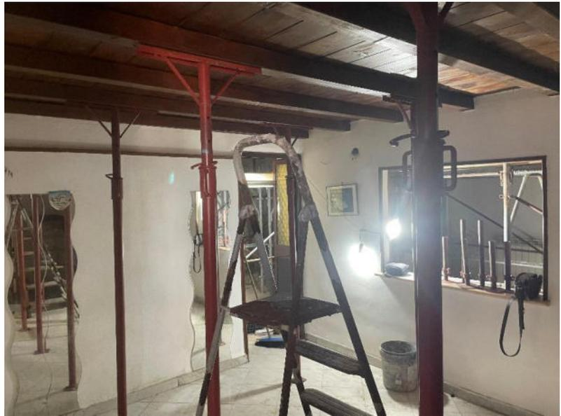
Figura 10 – Installazione puntelli e piano intermedio
