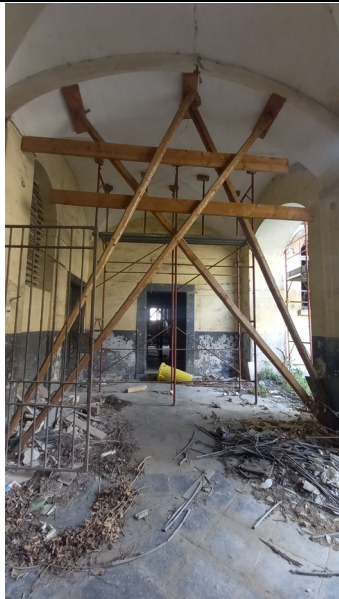
Figura 11: dettaglio puntellatura volte piano Terra
