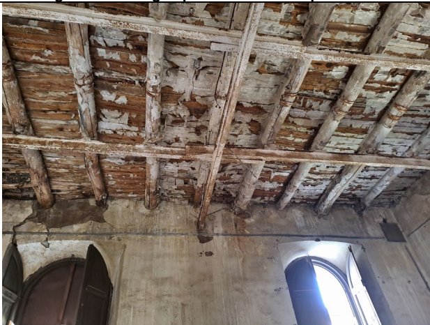
Figura 13: solai in legno
