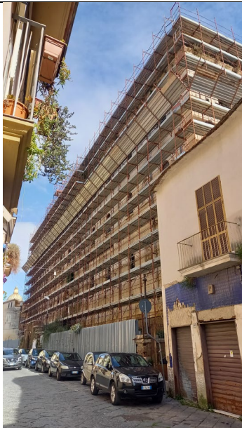
Figura 5: Prospetto da via Roma
