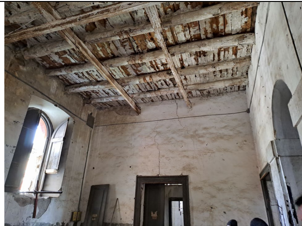
Figura 14: dettaglio solai in legno
