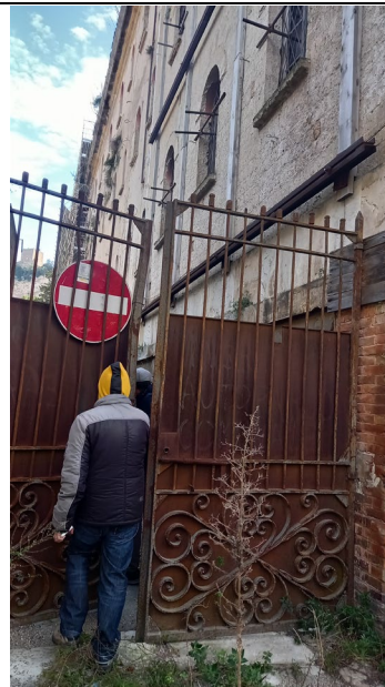
Figura 6: Accesso immobile da cancello posto in prossimità del prospetto Nord
