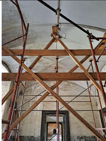
Figura 12: dettaglio puntellatura piani superiori
