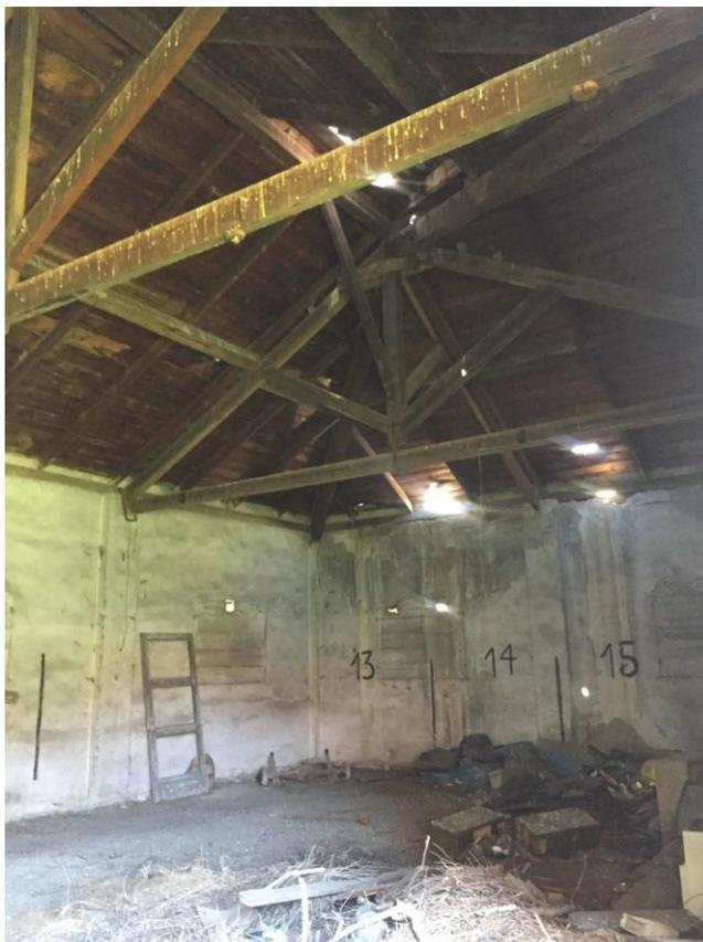
*Foto 9: particolare della carpenteria lignea della copertura*
