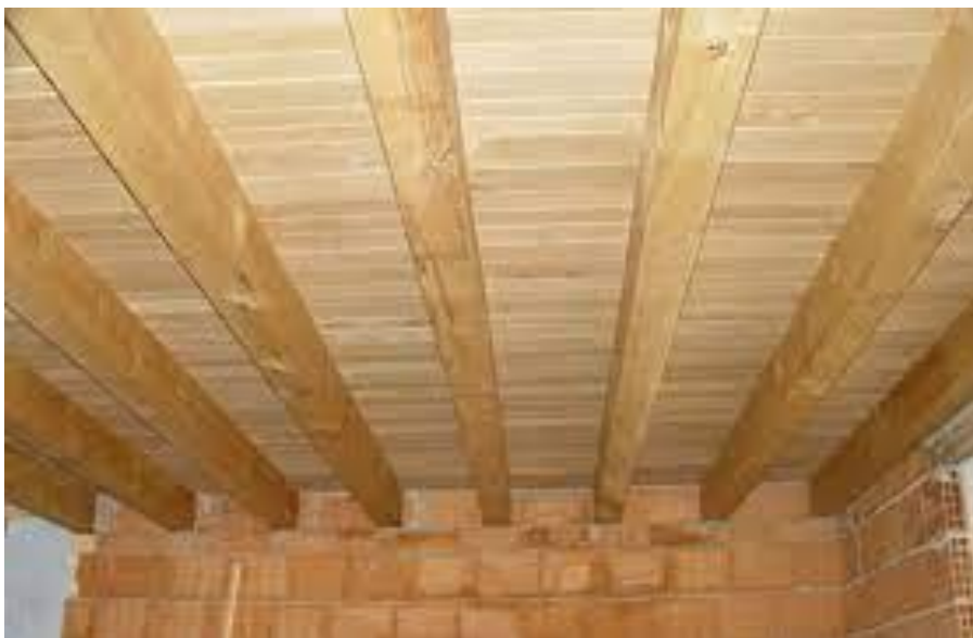
Figura 19: Esempio di solaio in legno in travi di legno lamellare
