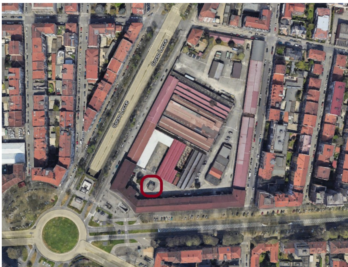
Fabbricato oggetto di intervento
