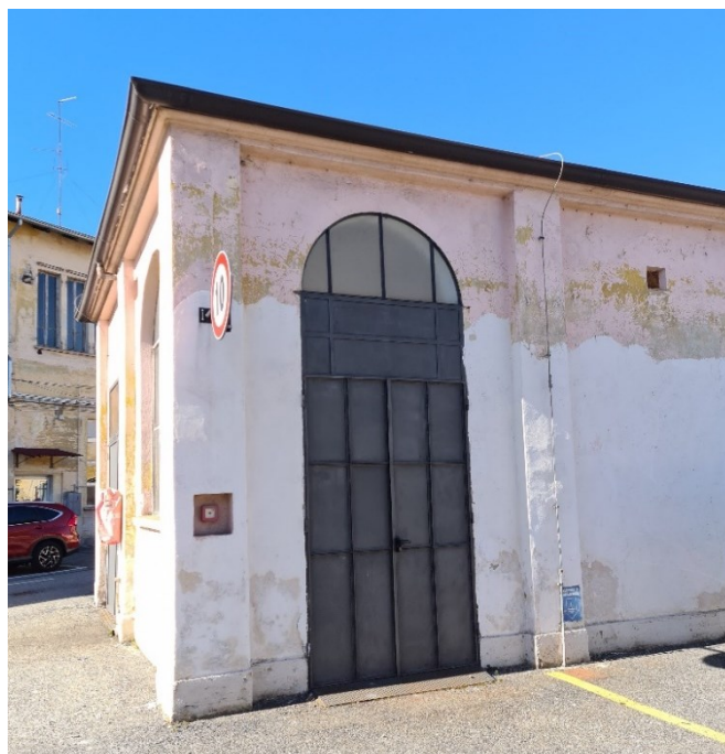
Prospetto su LATO B- Nord est
