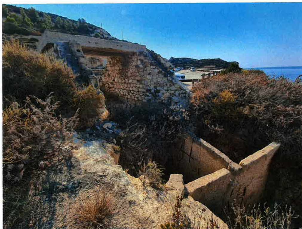
Varco, struttura di collegamento verticale con sottostante grotta
