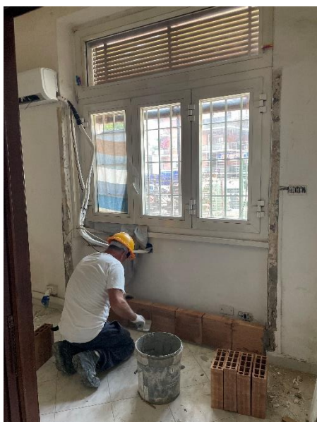
Figura 7 – Chiusura finestra lato strada
