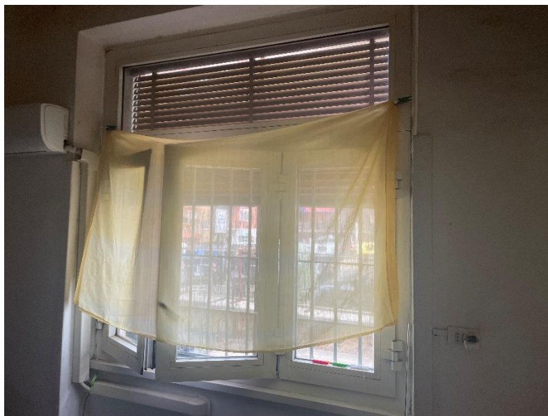
Figura 4 – Finestra lato strada
