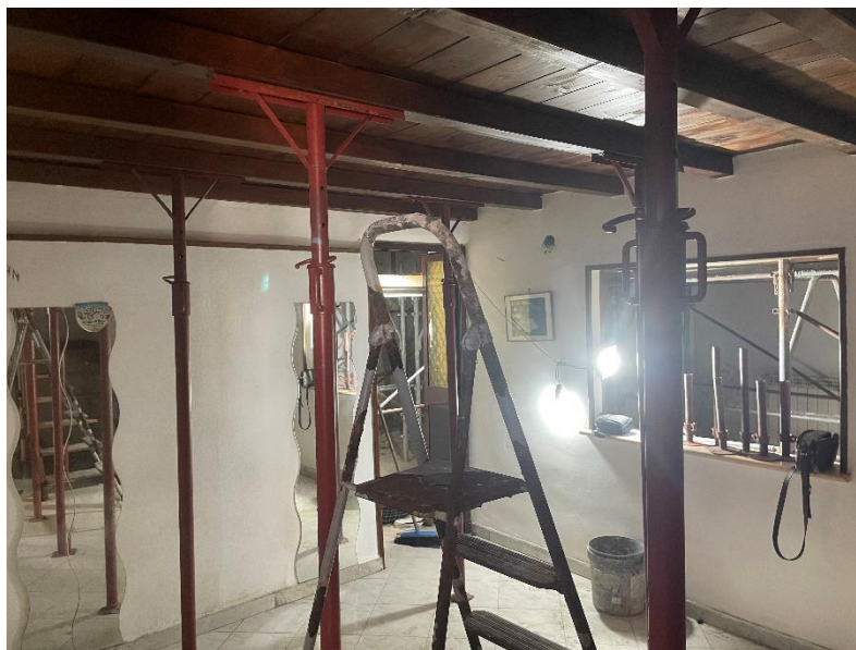
Figura 10 – Installazione puntelli e piano intermedio
