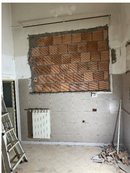
Figura 9 – Chiusura finestra lato strada
