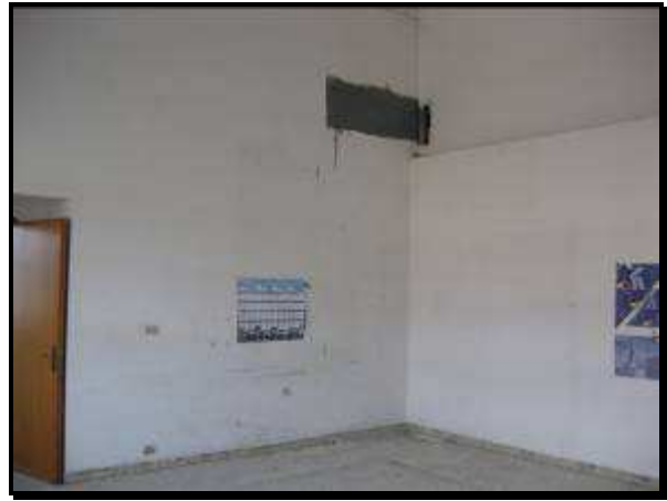
Foto 38 - Zona Archivi - Particolare rinforzi adeguamento sismico
