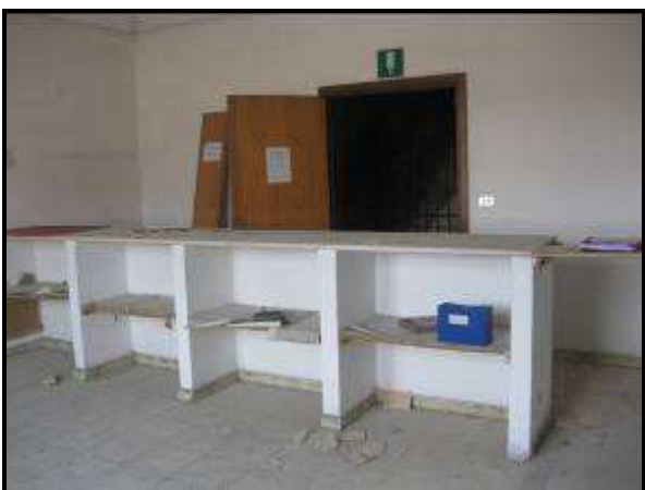
Foto 35 - Zona Archivi – Particolare bancone in muratura
