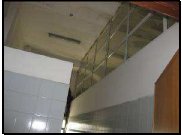
Foto 44 - Gruppo WC – Particolare lucernario verticale
