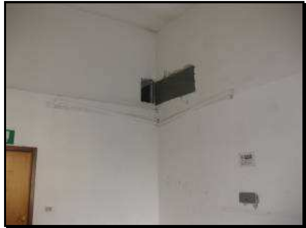
Foto 40 - Zona Archivi - Particolare rinforzi adeguamento sismico
