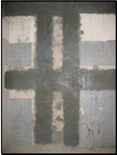
Foto 19 – Gruppo WC – Particolare rinforzi adeguamento sismico
