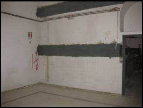
Foto 41 - Disimpegno 2- Particolare rinforzi adeguamento sismico
