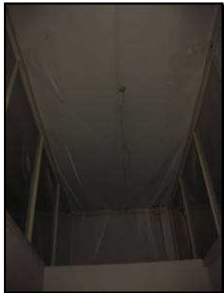
Foto 12 – Zona 2 – Particolare lucernari verticali
