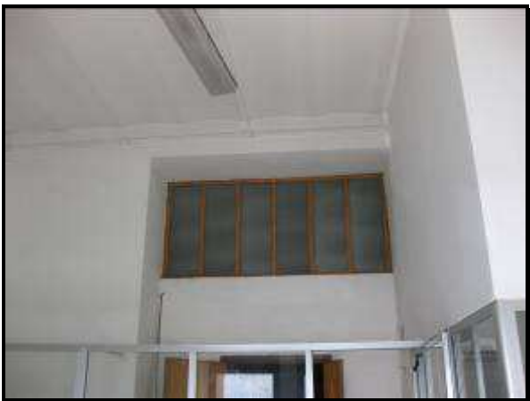
Foto 65 – Zona 8 – Particolare lucernario verticale
