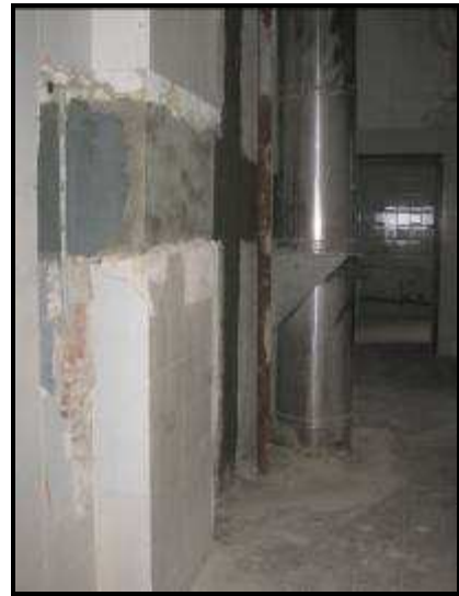
Foto 22 – Gruppo WC - Particolare rinforzi adeguamento sismico e canna fumaria centrale termica
