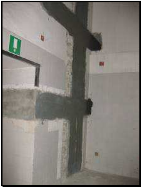
Foto 27 – Gruppo WC - Particolare rinforzi adeguamento sismico
