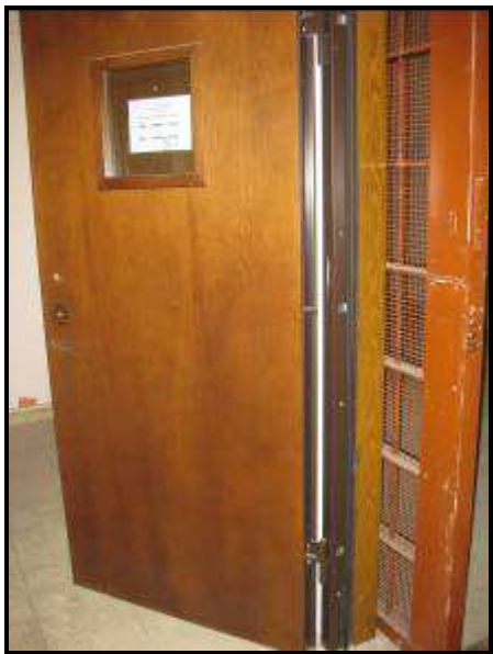
Foto 53 – Zona 5 - Particolare porta blindata
