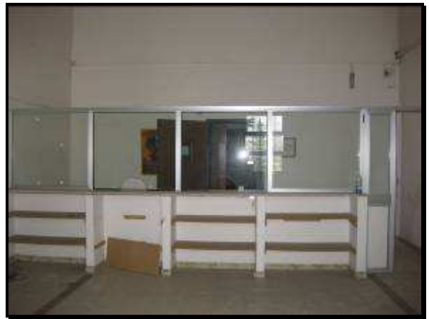
Foto 52 - Zona 5 - Particolare bancone in muratura
