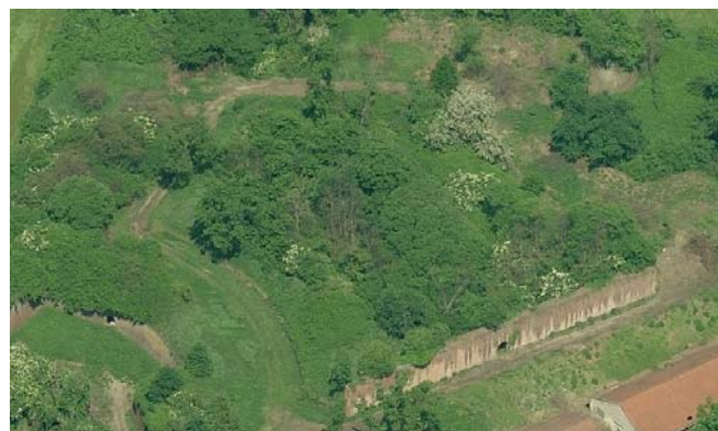
n.36 Bastione San Carlo Panoramica sud (1)
