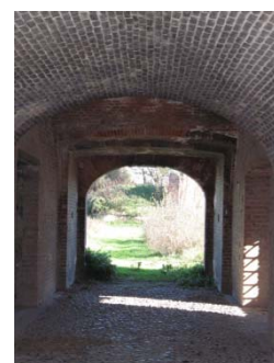
Corridoio 1° p. Porta Soccorso ( 3 )
