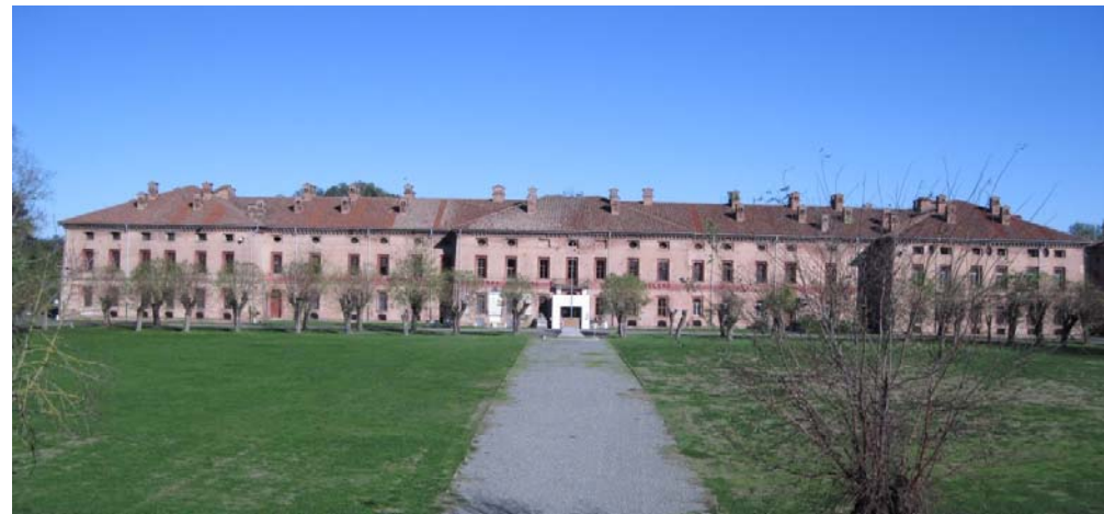
Caserma Beleno prospetto sud (2)
