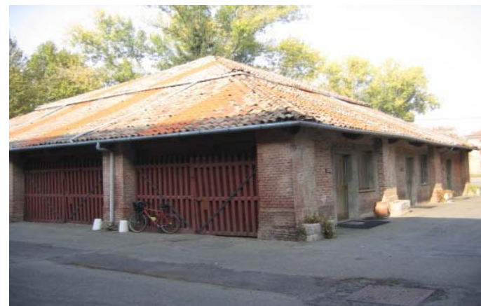
Prospetto sud Tettoia Novegno (1)
