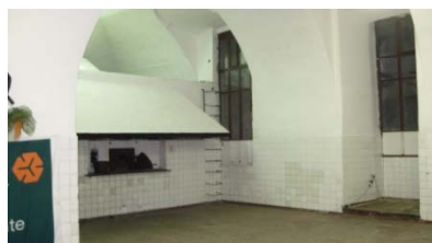
Zona forni p.t. (4)
