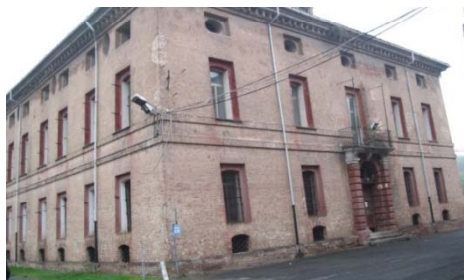
Caserma Beleno prospetto est (3)
