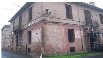
Caserma Montegrappa Prospetto ovest (3)
