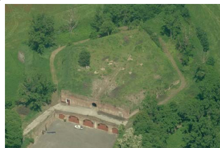
Bastione Santa Barbara Panoramica sud (5)
