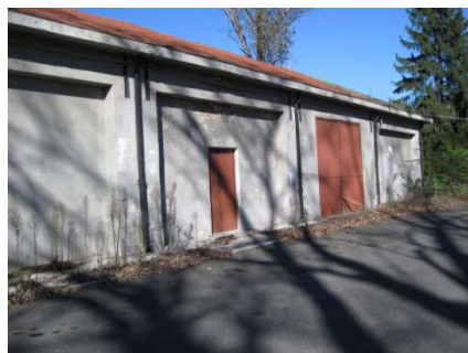
Capannone 21 Prospetto ovest (2)
