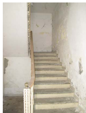
Ingresso vano scala (3)
