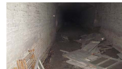
Ambienti piano interrato (9)
