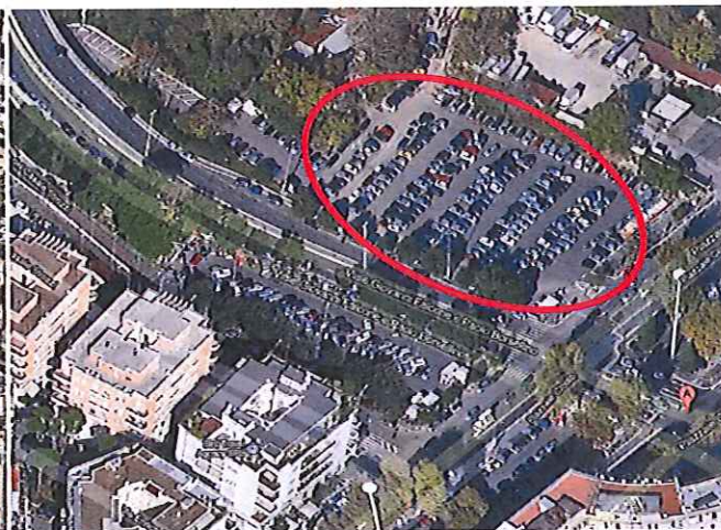
Rip. 2 - Ripresa aerea – Parcheggio a raso
