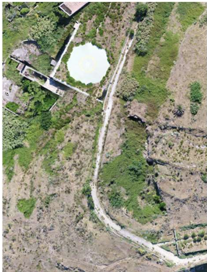
Stato di fatto. Sopralluogo 17/09/2020
