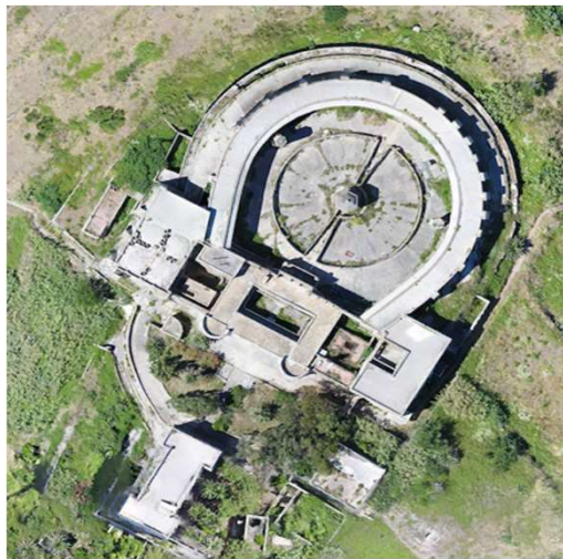
Stato di fatto. Sopralluogo 17/09/2020
